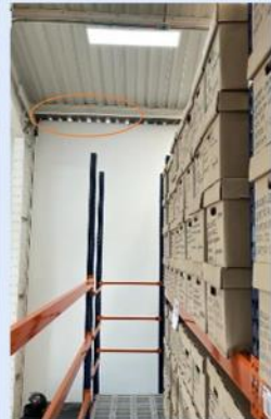
Entreluces debajo de la puerta y en techos posible punto de ingreso de plagas al depósito de archivo
