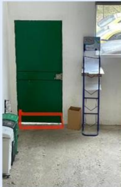
Entreluces debajo de la puerta y en techos posible punto de ingreso de plagas al depósito de archivo
